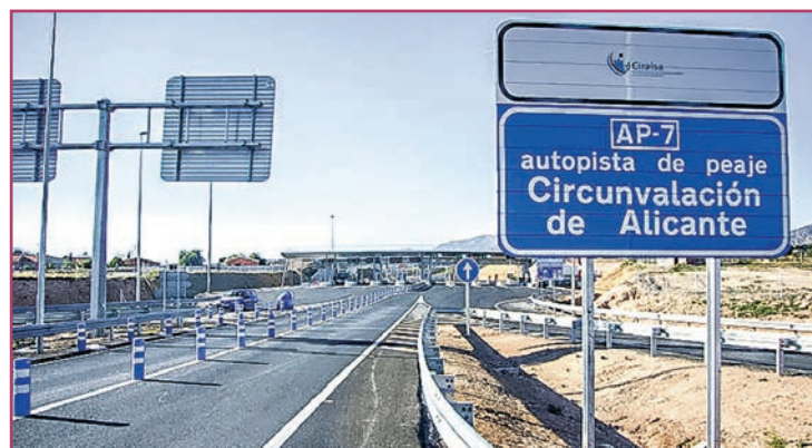
Autopista del Mediterráneo.
