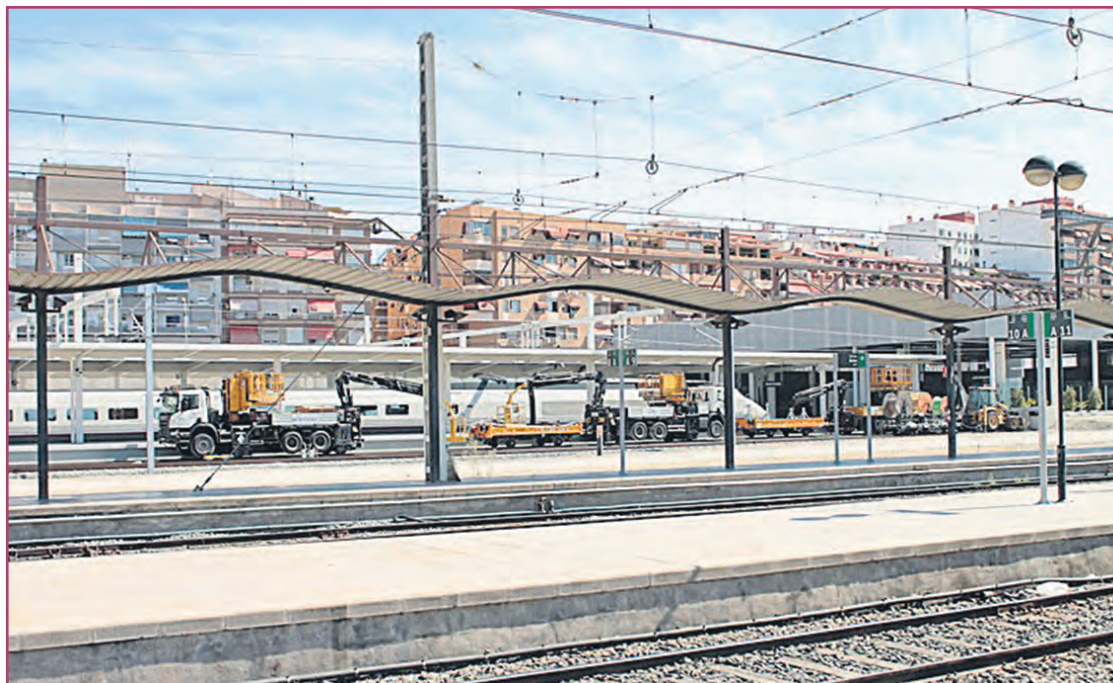
Obras en la Estación.
