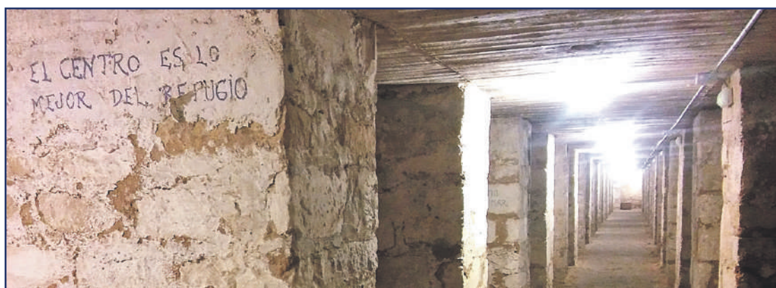
Pasillo central del refugio de Séneca | Centro de Interpretación de la Guerra Civil en Alicante
