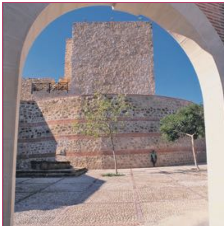
Detalle del castillo tras las obras de recuperación.
