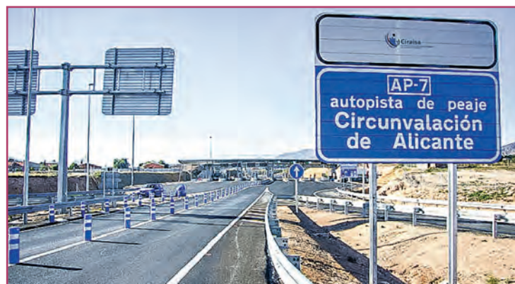
Autopista del Mediterráneo.
