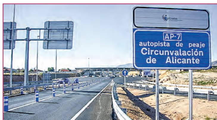
Autopista del Mediterráneo.
