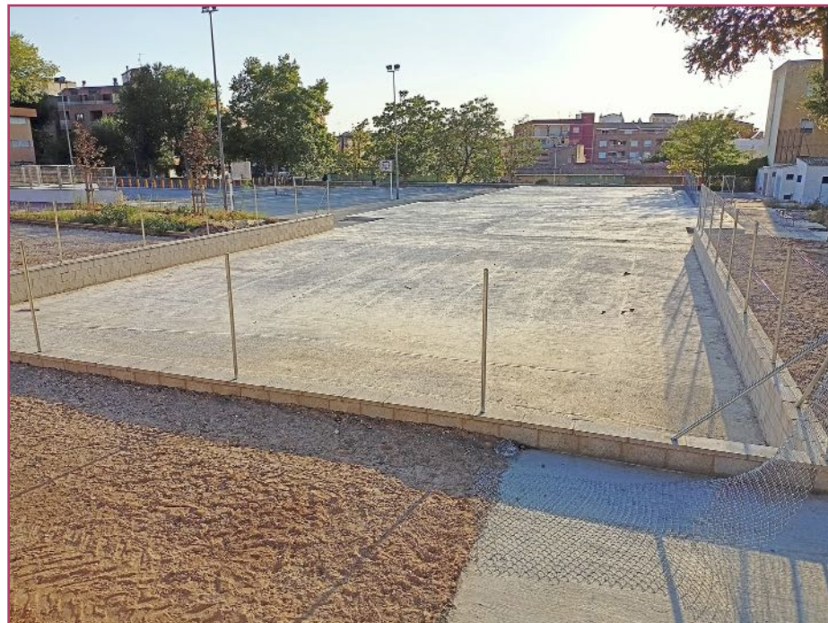
Solera preparada para aulas prefabricadas.
