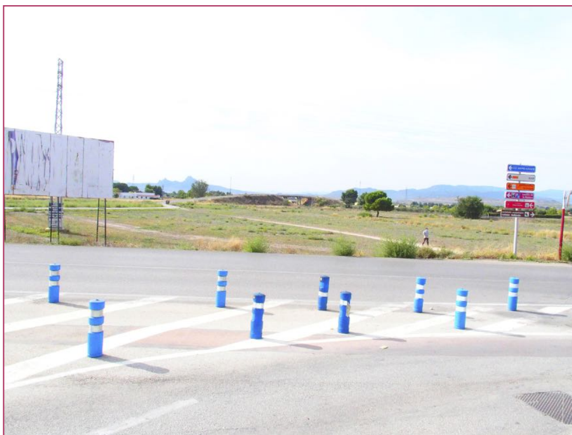
Actuaciones en la supresión del paso a nivel.
