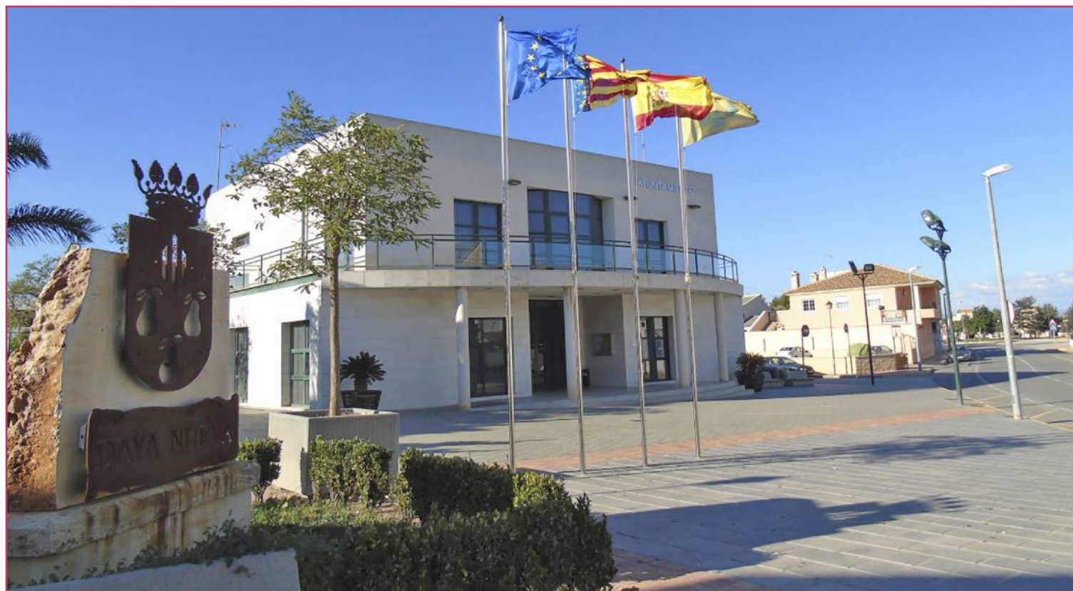
En Daya Nueva se realizará una prueba piloto para que el ayuntamiento sea 100% independiente energéticamente.
