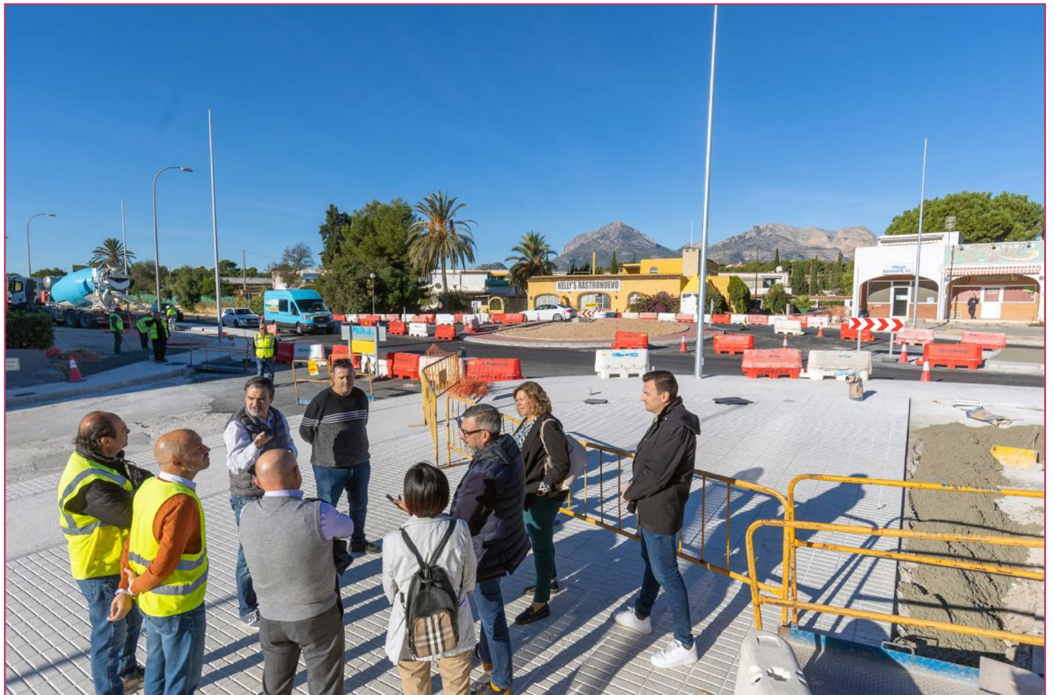
El Alcalde junto a técnicos y políticos municipales supervisando la obra.
