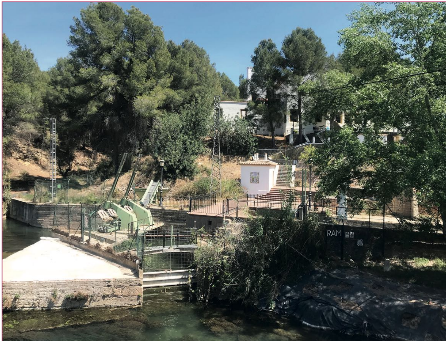
Vista de la Casa Azud desde el lado del río Turia que da a Manises.
