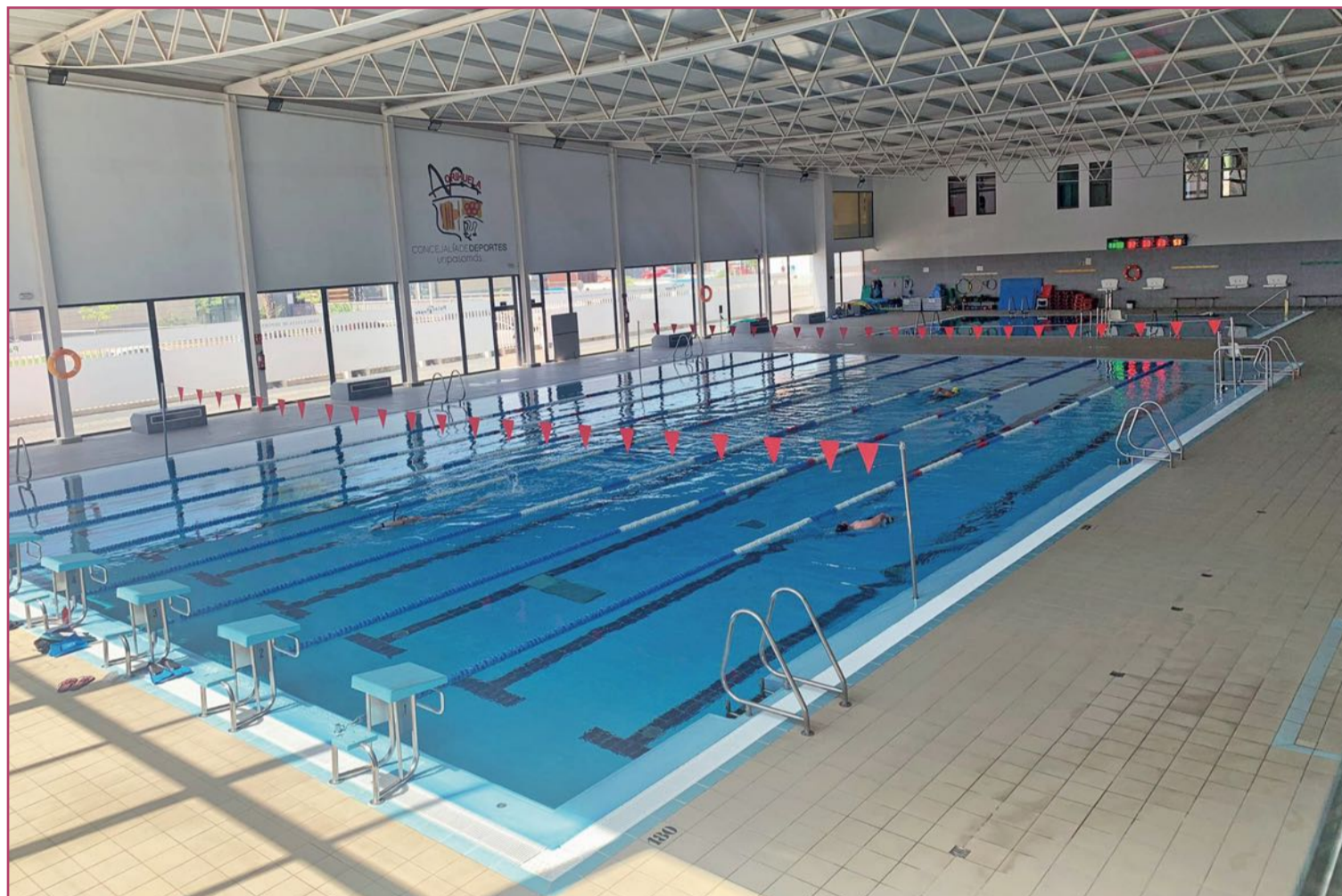
En el Palacio del Agua se instalarán 152 módulos solares.
