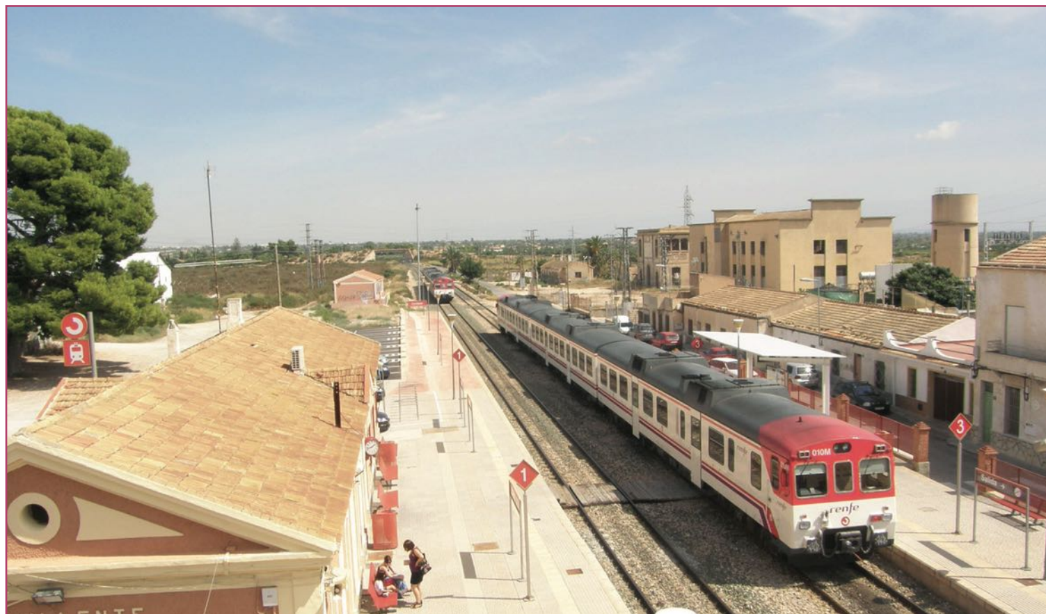
El Cercanías Alicante-Murcia pasando por Crevillent.
