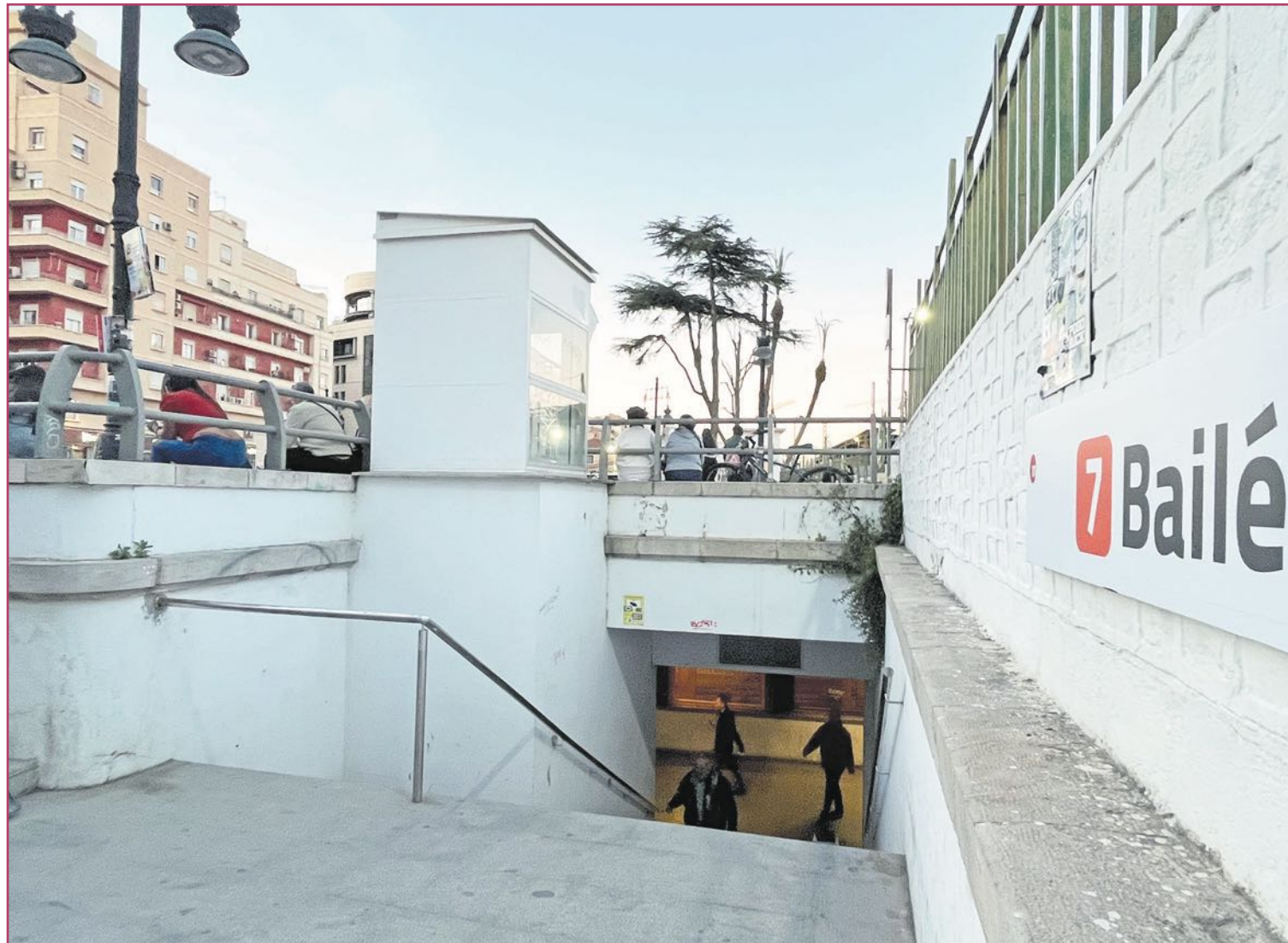
Entrada al túnel por la calle Bailén.
